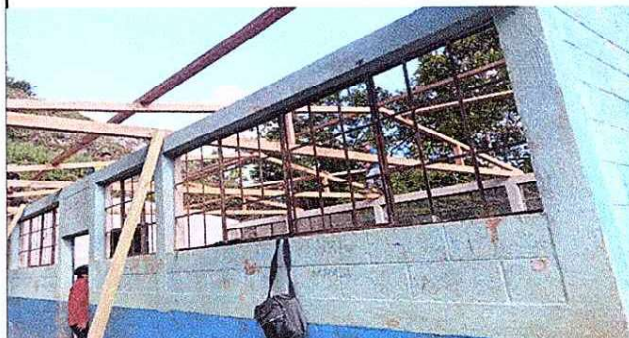
Foto 2: Modulo 1: Sustitucion de estructura de soporte de madera, por metal , sutitucion de vidrios, mantenimiento de puerta y mantenimiento de pintura interior y exterior.
