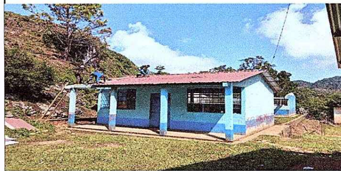
Foto 4: Modulo 2: Sustitucion de vidrios, mantenimientos de puerta y mantenimiento de pintura interior y exterior.
