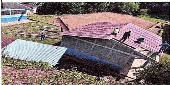
Foto 3: Modulo 2: sustitucion de láminas, por laminas troqueladas aluzinc
