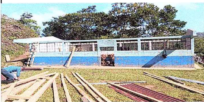
Foto1: Modulo 1: sustitucion de laminas , por laminas troqueladas aluzinc
