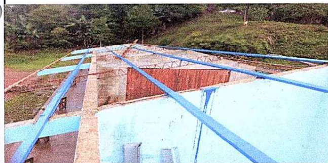
Foto 5: Modulo 3: Sustitucion de laminas, por laminas troquelada aluzinc y mantenimientos de una hilada de costanera.
